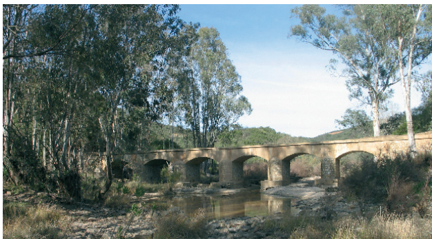
Panorámica del Puente Matachica, en la recta final de la Ruta. / Panoramic view of Matachica Bridge, on the final stretch of the Trail.
